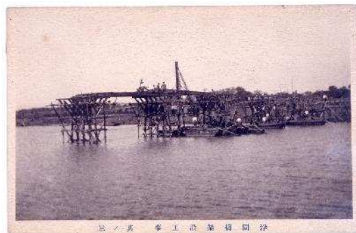
「浮間橋架設工事絵葉書」
